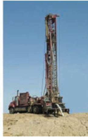
دکل حفاری چاه آب
