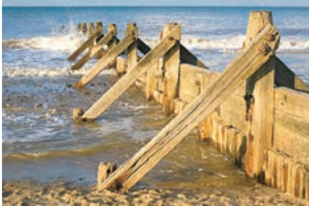
نصب حفاظ عمودی
