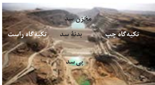
شکل ۵-۴: نمایی از بخش‌های مختلف یک سد
