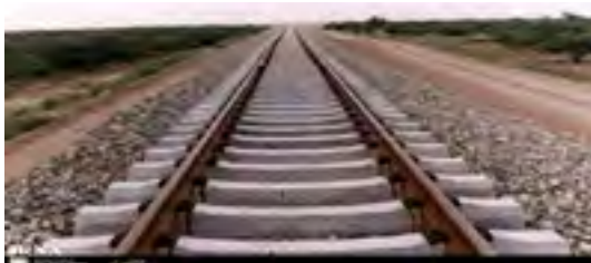
شکل ۱۱-۴: بالاست در زیرسازی جاده ریلی
