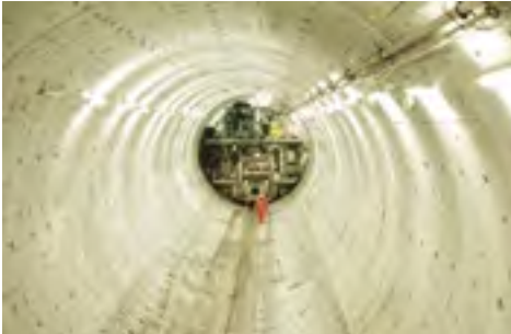
شکل ۶-۴: پوشش داخلی تونل به وسیله قطعات بتن
