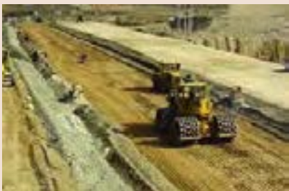
مراحل ساخت سد خاکی
