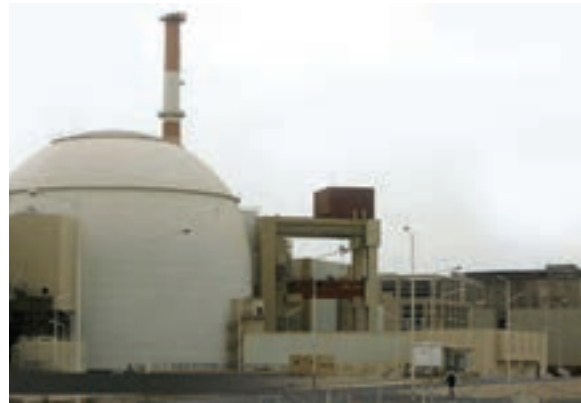
شکل ۶-۱۳ الف) نیروگاه ۱۰۰۰ مگاواتی شکافت هسته‌ای بوشهر. راکتور آب تحت فشار (PWR) این نیروگاه، در زیر قسمت گنبدی شکل قرار دارد. ب) طرح‌واره‌ای از یک راکتور PWR و قسمت‌های اصلی یک نیروگاه شکافت هسته‌ای
