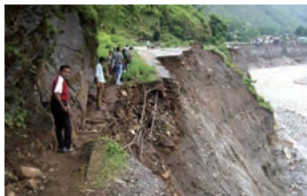
لغزش در اثر زیربُری رودخانه در هند
