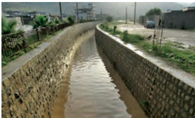
هدایت و انحراف جریان سیلاب رودخانه توسط کانال‌های فرعی در مسیر زاینده رود
