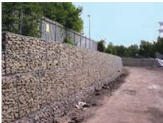
دیواره حائل برای حفاظت از سکونتگاه‌های حاشیة رودخانه گرمابدره سرشاخه جاجرود در استان تهران
