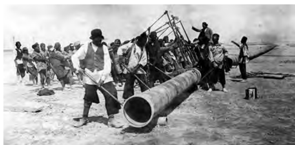
کارگران شرکت نفت هنگام احداث خط لوله نفت در خوزستان
