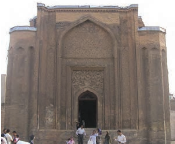
گنبد علویان از بناهای دورهٔ سلجوقی، همدان
