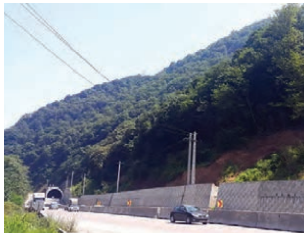
نصب حفاظ بتونی - جاده قائم‌شهر
