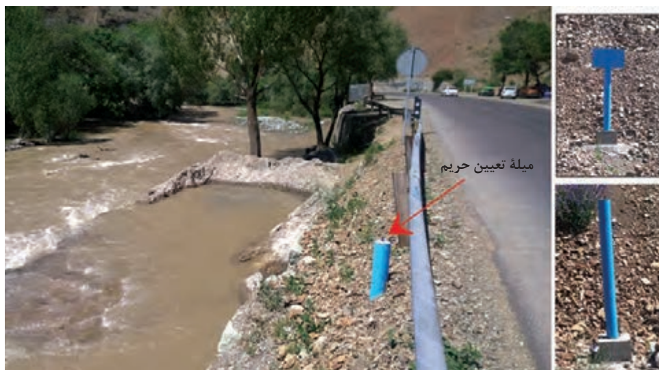
میلۀ تعیین حریم سیل گیر رودخانه کرج در بالادست سد امیرکبیر
