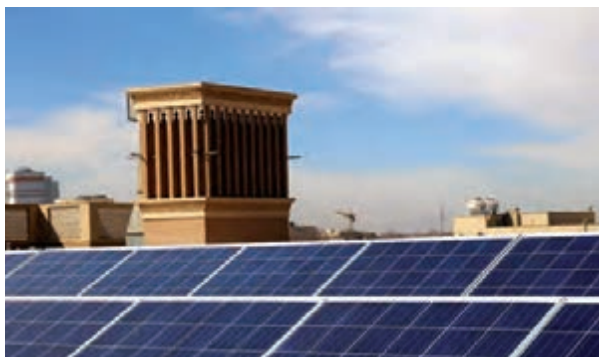
با اجرای طرح بام تا بام، تجهیز ۱۰۰۰ منزل مسکونی در شهر یزد به انرژی خورشیدی، از سال ۱۳۹۶ آغاز شده است.
