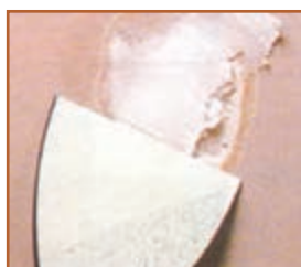
ب - لکه گیری و ترمیم ترک‌ها
