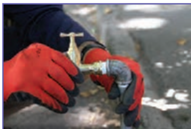
ت- بستن شیر با دست به لوله
