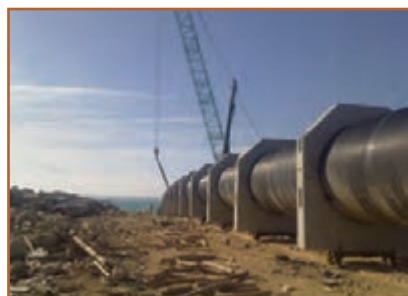
ت - احداث خطوط لوله
