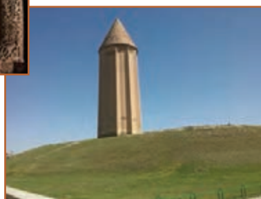
شکل ۲۷-۸- بنای گنبد قابوس، بلندترین برج آجری دنیا
