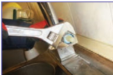
ث- باز کردن پیچ روی مغزی (گلند)
