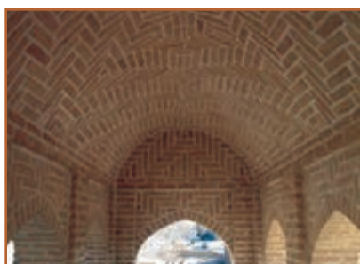
ب- استفاده از آجر برای سقف قوسی
