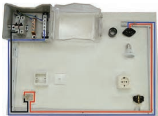
شکل ۶-۸ - انجام سیم کشی روشنایی
