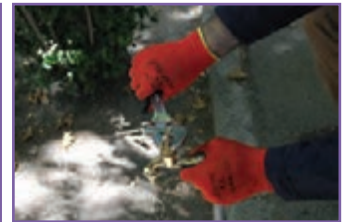
پ - باز کردن کلگی شیر با آچار در جهت خلاف حرکت ساعتگرد
