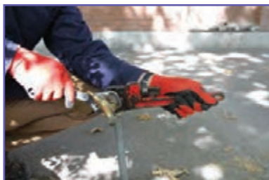
ب- باز کردن شیر با دو آچار (به جهت انداختن آچارها توجه کنید).
