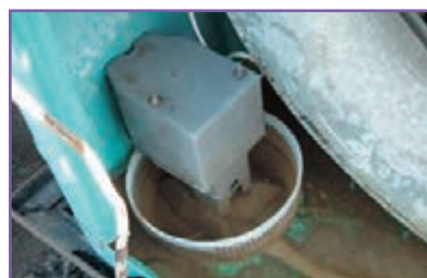
ج- بررسی و تمیز کردن پمپ آب
