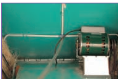
ح- آزمایش صحت مدار آب پخش کن
