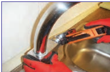
ب- باز کردن دسته شیر با آچار آلن
