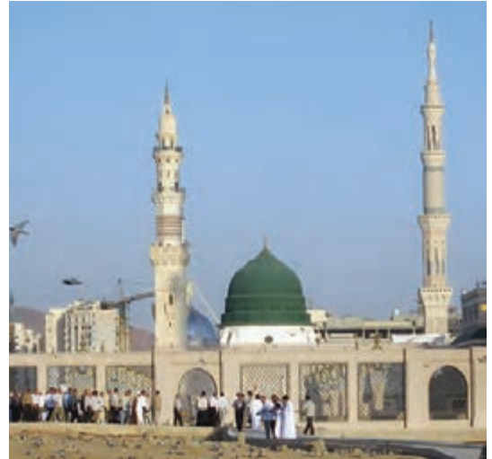
مسجد النبی، نمای بیرونی
